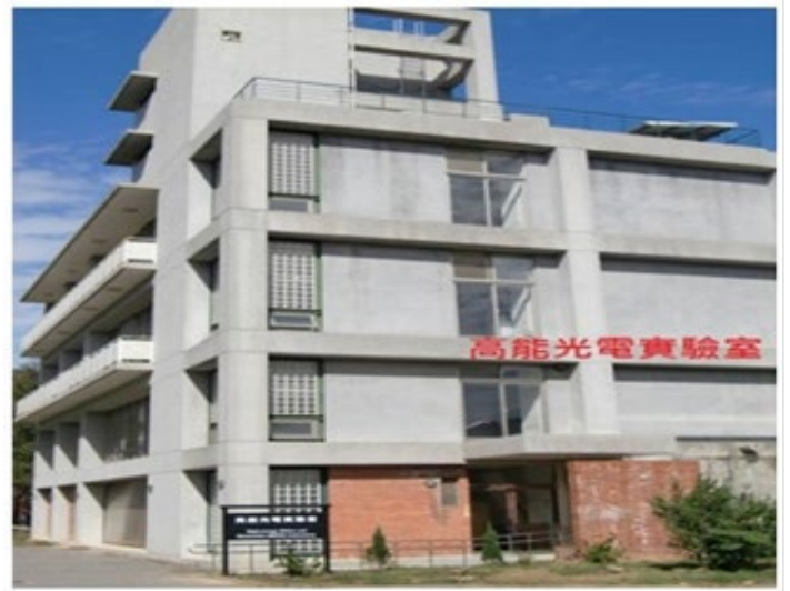
8 高能光電實驗室
